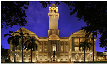
维多利亚剧院和维多利亚音乐厅 2015 IESNA 照明奖 / 入围奖
