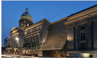
新加坡国家美术馆 2017 IALD 入围奖 2016 IESNA 照明奖 / 入围奖
