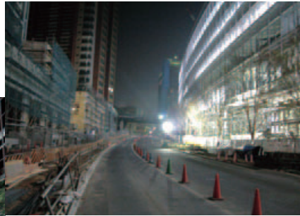
10. けやき坂通り、この時点ではまだ街路灯は建柱されていない。 10. Keyakizaka Dori before the street lights were installed.
